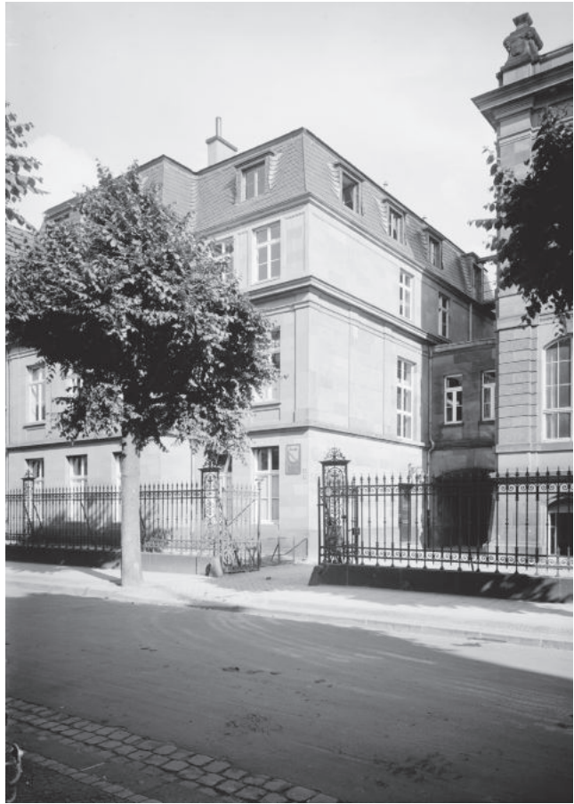
Abb. 10 Das rheinische Denkmalamt in der Bonner Bachstraße nach der Aufstockung im Jahr 1935. Das Foto machte Bernhard von Tieschowitz, wissenschaftlicher Hilfsarbeiter des Amtes
