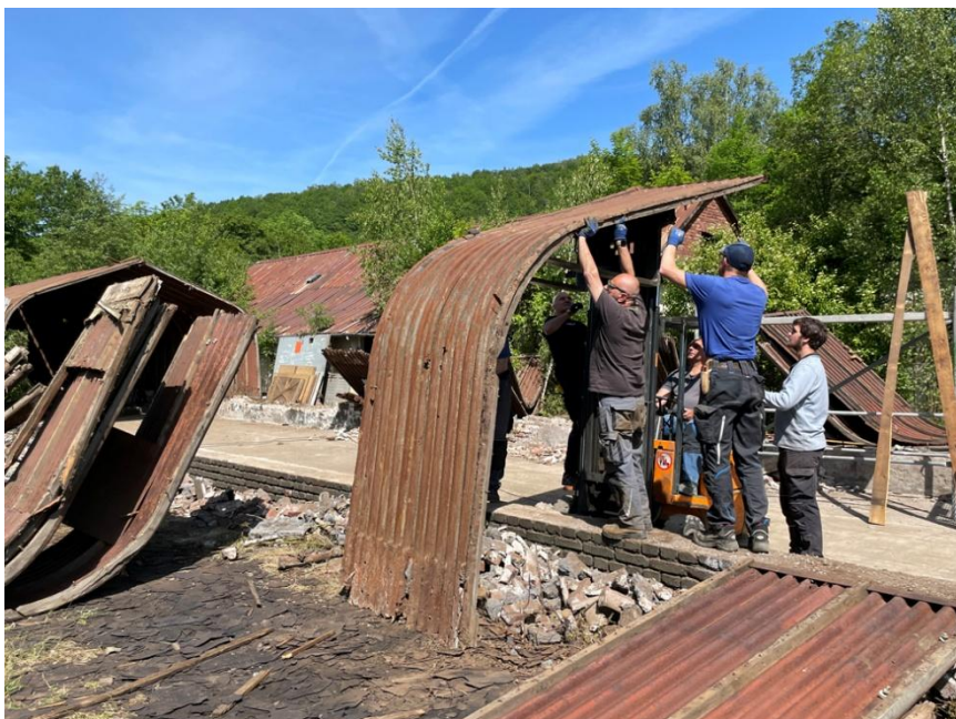
Abb. 15 + 16. Die Rückbauarbeiten erfolgten überwiegend von Hand und konnten Ende Mai 2023 abgeschlossen werden.
