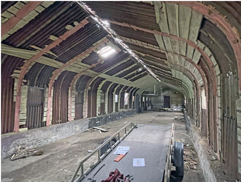
Abb. 14. Im Innern erscheint die Wellblechbaracke größer, als sie tatsächlich ist. Im Museum wird der einst den First bekrönende Lüftungsreiter rekonstruiert werden.
