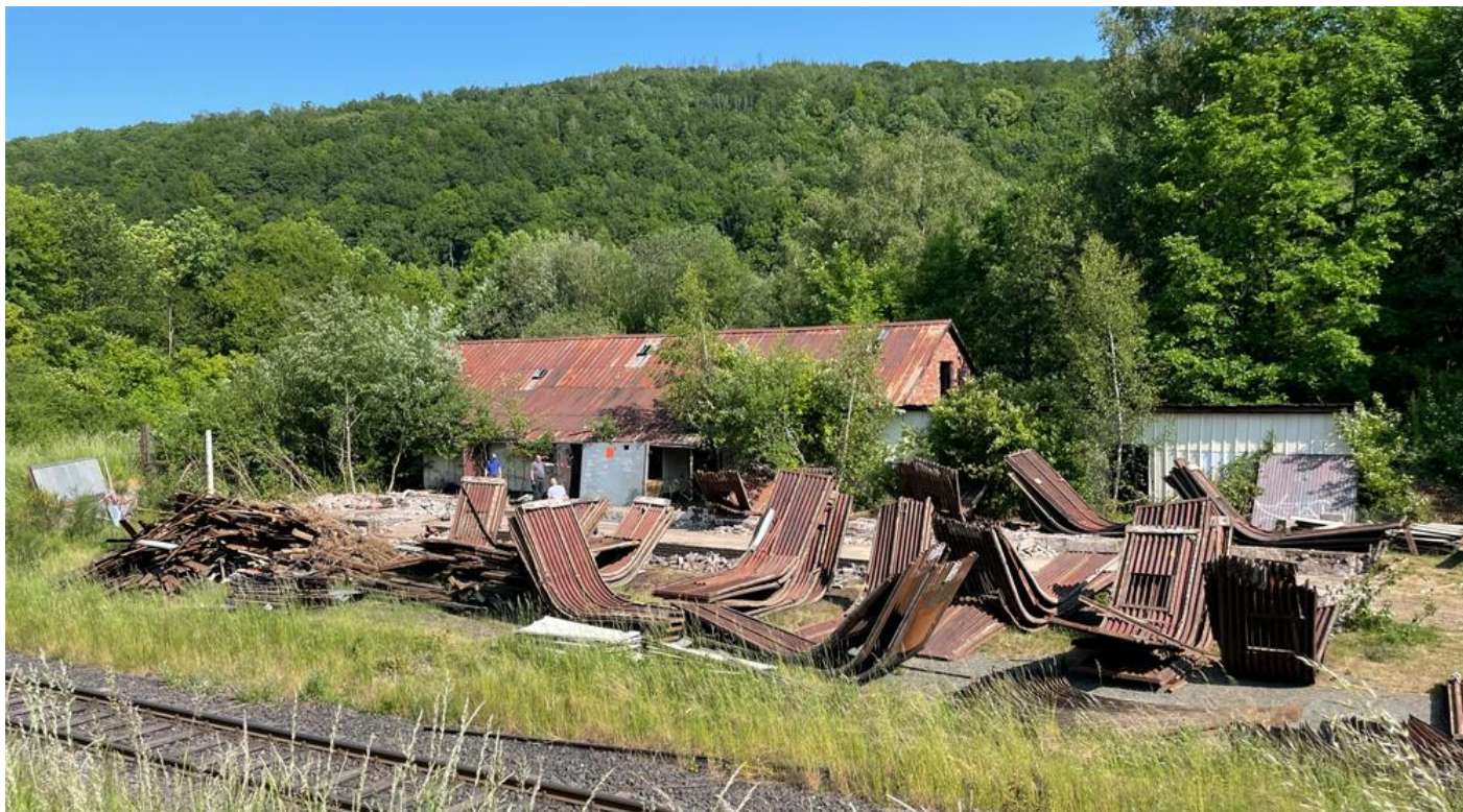
Abb. 17. Die in ihren 60 Wandsegmenten zerlegte Wellblechbaracke in den ersten Junitagen 2023. Kurze Zeit später erfolgte der Abtransport in das LVR-Freilichtmuseum Lindlar.
