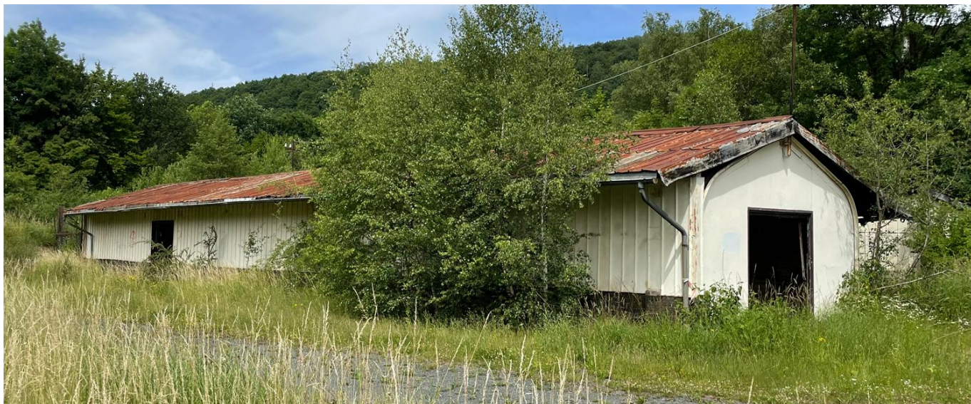
Abb. 9. Die 31,5 Meter lange Wellblechbaracke mit Überdachung von 1920 vor dem Abbau im Mai 2023
