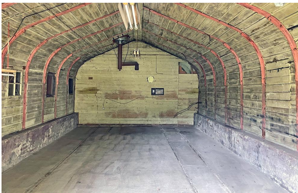
Abb. 10. Innenansicht vor dem Rückbau mit verbretterten Wellblechwänden sowie Sockel aus Mauerwerk. Im Fundament sind zwei Gleisstränge in 600mm-Spurweite erkennbar, die in einer kleinen Drehscheibe (Teile vom Museum geborgen) einmündeten.
