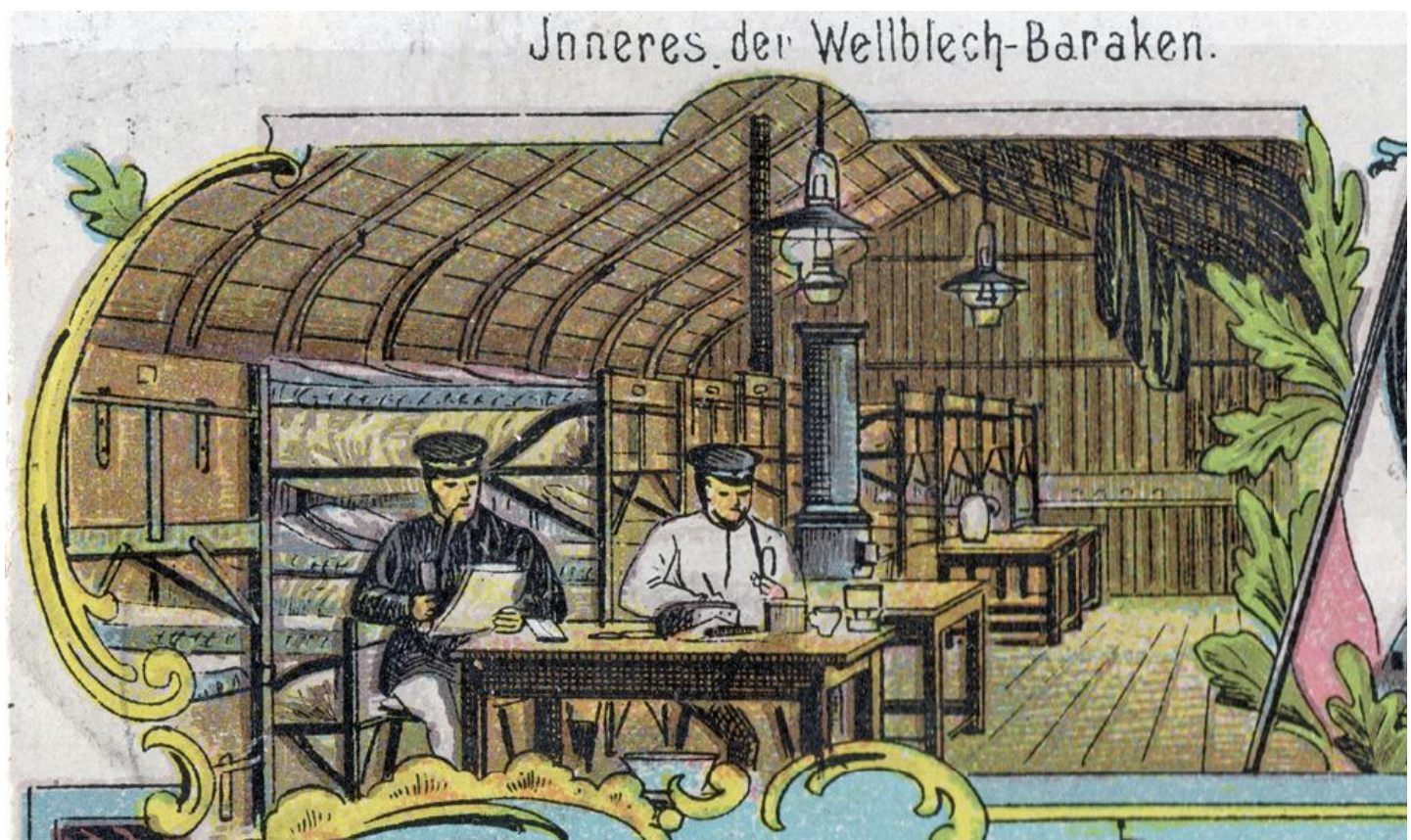
Abb. 8. Postkartenausschnitt, der das Innere einer militärisch genutzten Wellblechbaracke um 1900 in Elsenborn zeigt. Die Wände waren mit Holz verkleidet, das auch in Neunkirchen wiederverwendet wurde.
