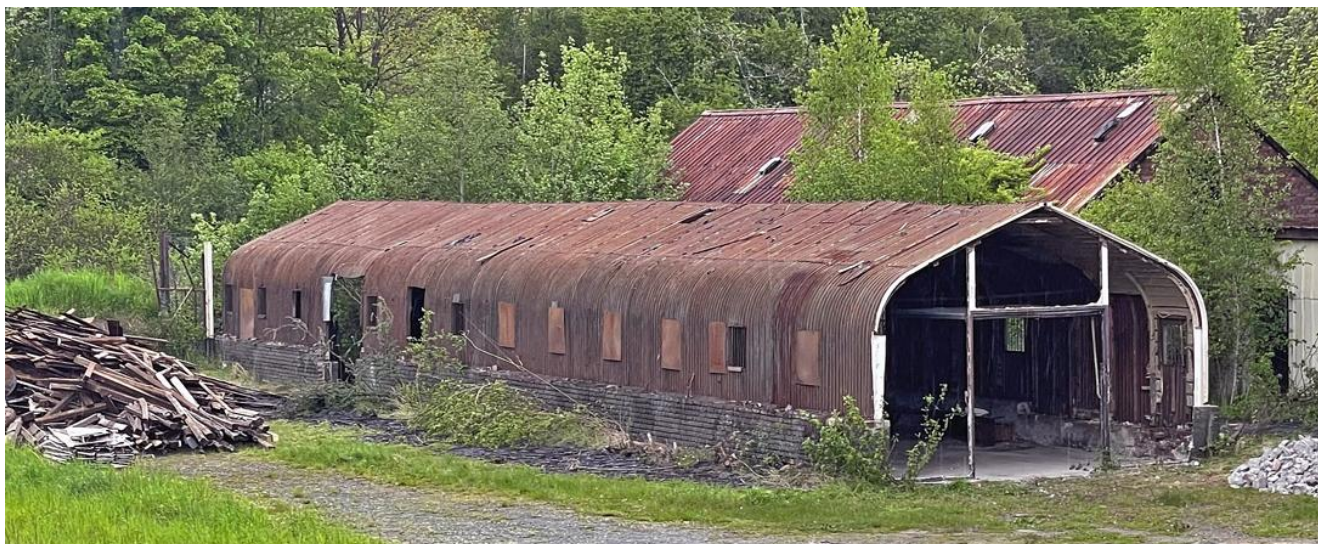
Abb11. Die Wellblechbaracke ohne nachträgliche Überdachung am 13. Mai 2023.
