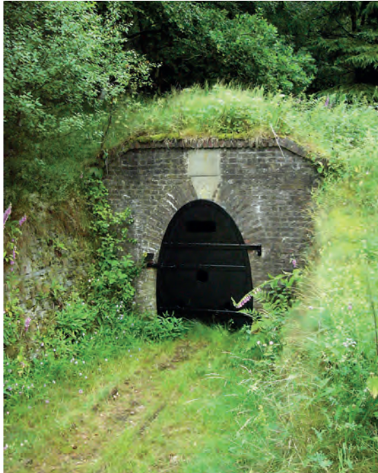
Abb. 30: Mundloch des Stollens Altenberg (Foto: Altenberg & Stahlberg e.V Müsen/R. Golze).
