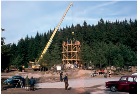
Abb. 8: Aufstellung des ersten Aussichtsturms im März 1975 (Foto: LWL-Archäologie für Westfalen).
