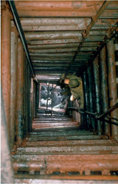
Abb. 7: Schacht 2 wurde ausgegraben, indem um ihn herum ein neuer Schacht angelegt und abgetieft wurde. Zugleich konnte so der mittelalterliche Schacht freigelegt und geborgen werden (Foto: Deutsches Bergbau-Museum Bochum).
