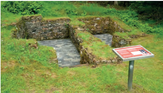
Abb. 24: An Fundstelle 28 (hier die aufgemauerten Fundamente) wurden zwei Keller aus Platzmangel direkt nebeneinander gebaut (Foto: LWL-Archäologie für Westfalen/M. Zeiler).
