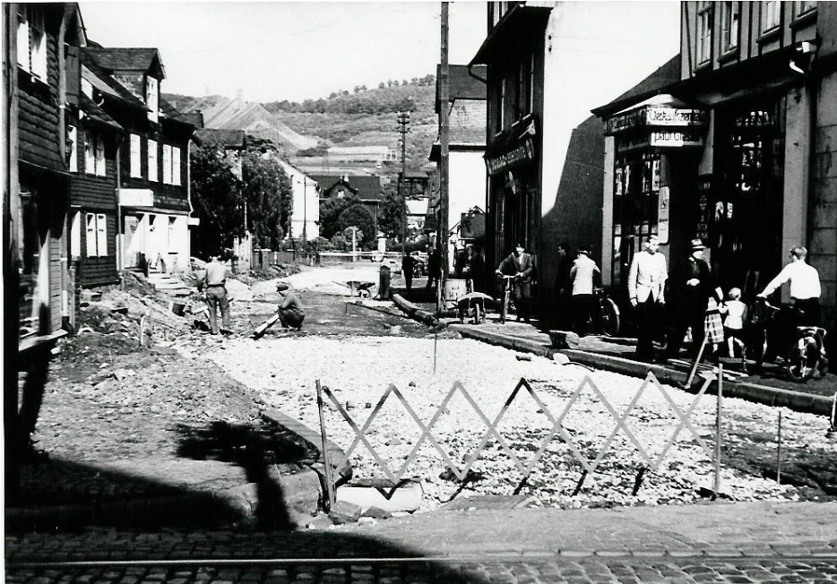
Die Bahnhofstraße wird gepflastert.
