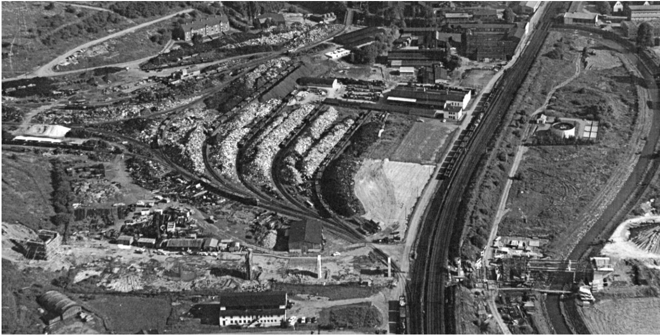
Bau der neuen Setzer Straße
