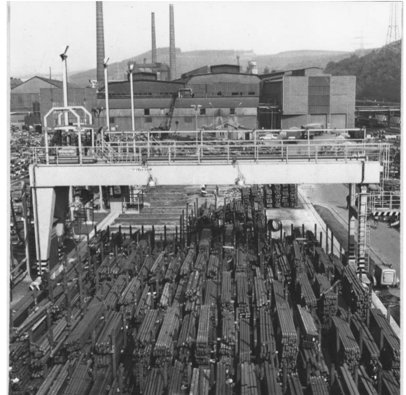
Vormaterial der Stabstahlstraße
