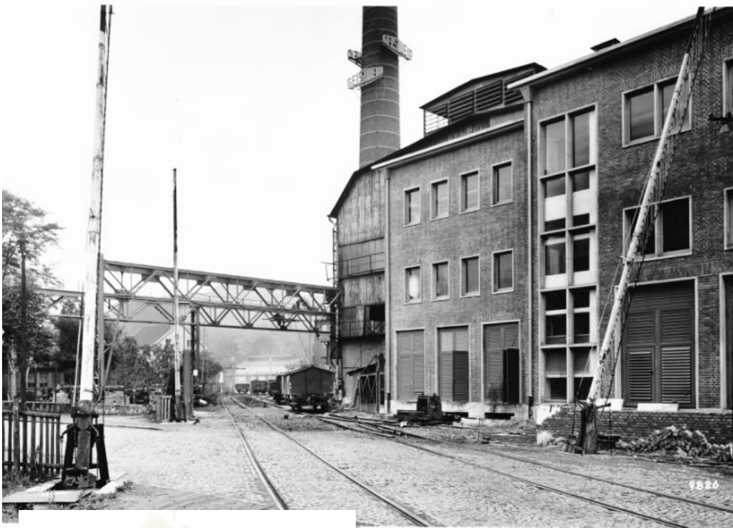
1928: Schranke am Übergabegleis ins Werk,
