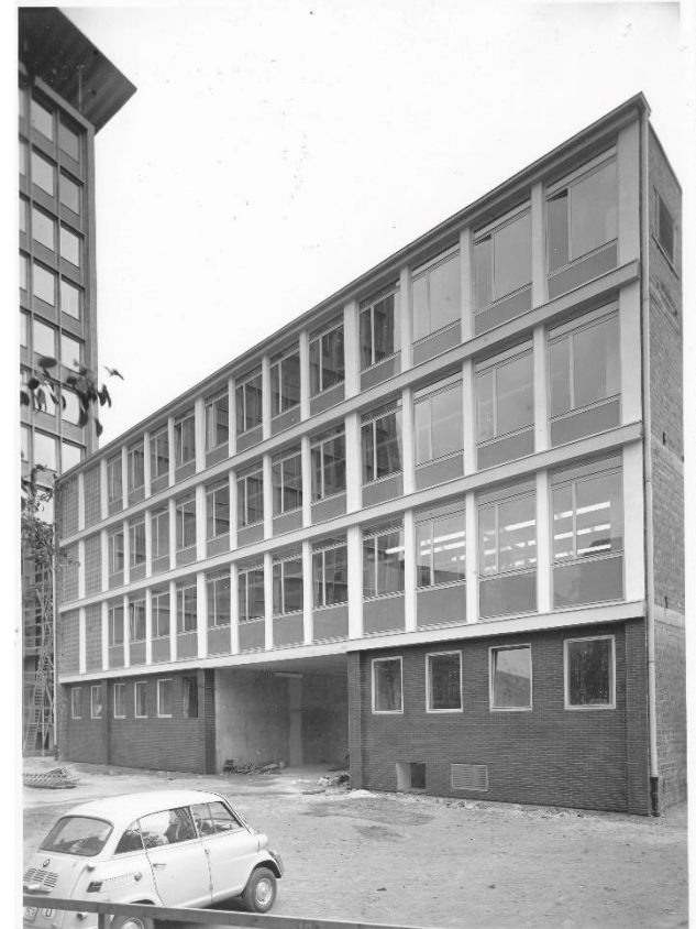
Im nächsten Bauabschnitt folgte das Rechenzentrum
