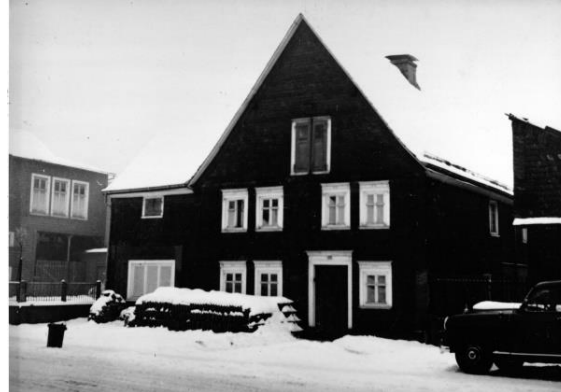
UK-Str. 43, F. Schürmann, Dachdecker
