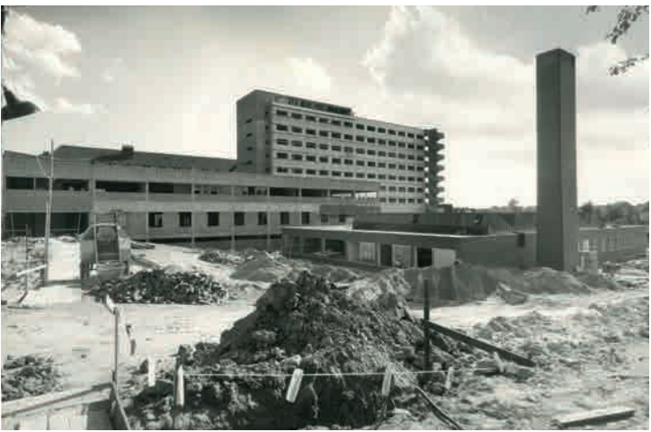
Bau des Kreiskrankenhauses Lemgo, um 1964. (Abb.: Kreisarchiv Lippe)
