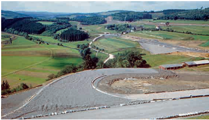
Tunnelbau am Erbscheidberg bei Sondern im Zuge der Errichtung der Biggetalsperre, Juli 1960. (Abb.: LWL-Medienzentrum für Westfalen/ Hans Hild)
