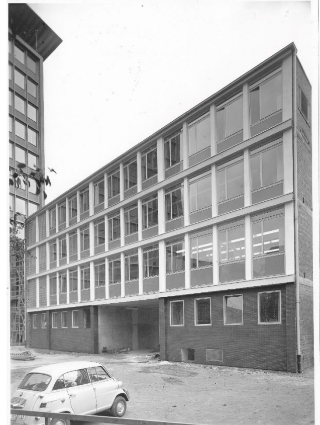
Im nächsten Bauabschnitt folgte das Rechenzentrum Die neue Hauptverwaltung der Stahlwerke Südwestfalen AG
