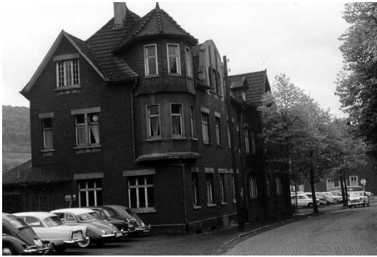
UK-Str. 55, Metzgerei Seip, am Teich. Zuletzt Büro, Stahlwerke
