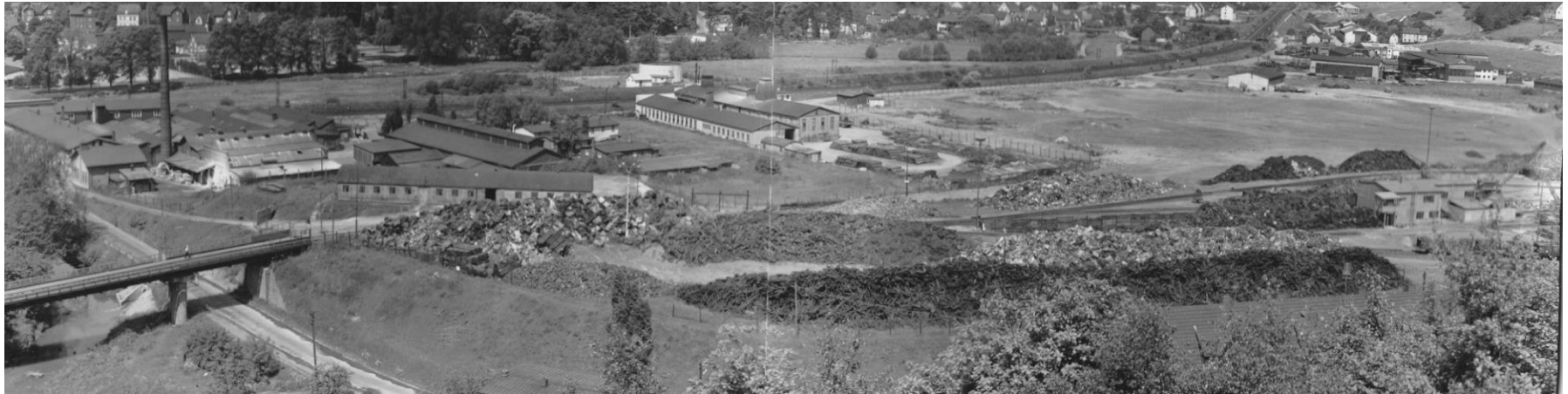
Setzer Wiesen, 1962. Die Notunterkünfte sind verschwunden, das Gelände wurde planiert, die Setze verrohrt. Der Bereich wird als Schrottplatz genutzt.
