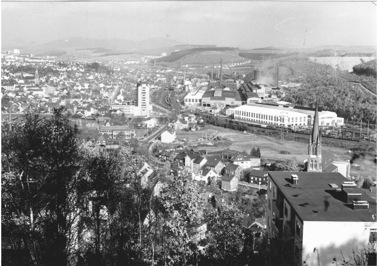
1969: Die „Kaiser-Halle“ ist verlängert. Auf dem Gelände der „Bremer Hütte“ stehen die neuen Hallen der Stabstahl-Adjustage („Bremer Halle“) und der Wärmebehandlung.
