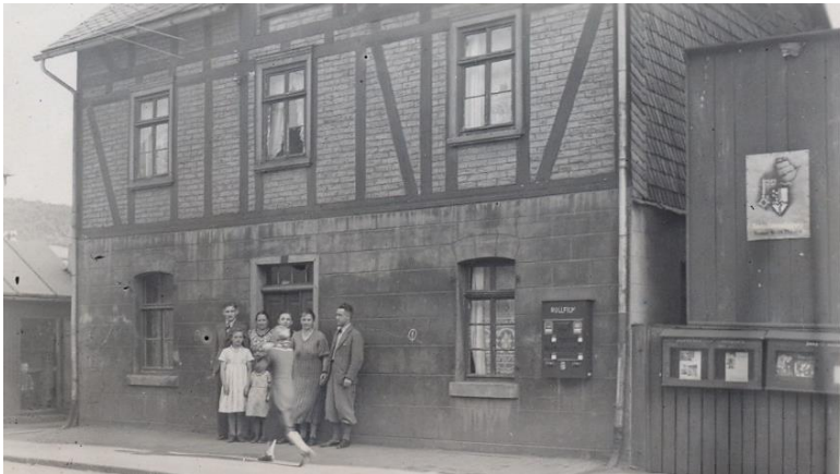
Bahnstraße 8, Haus Dittmann 1935
