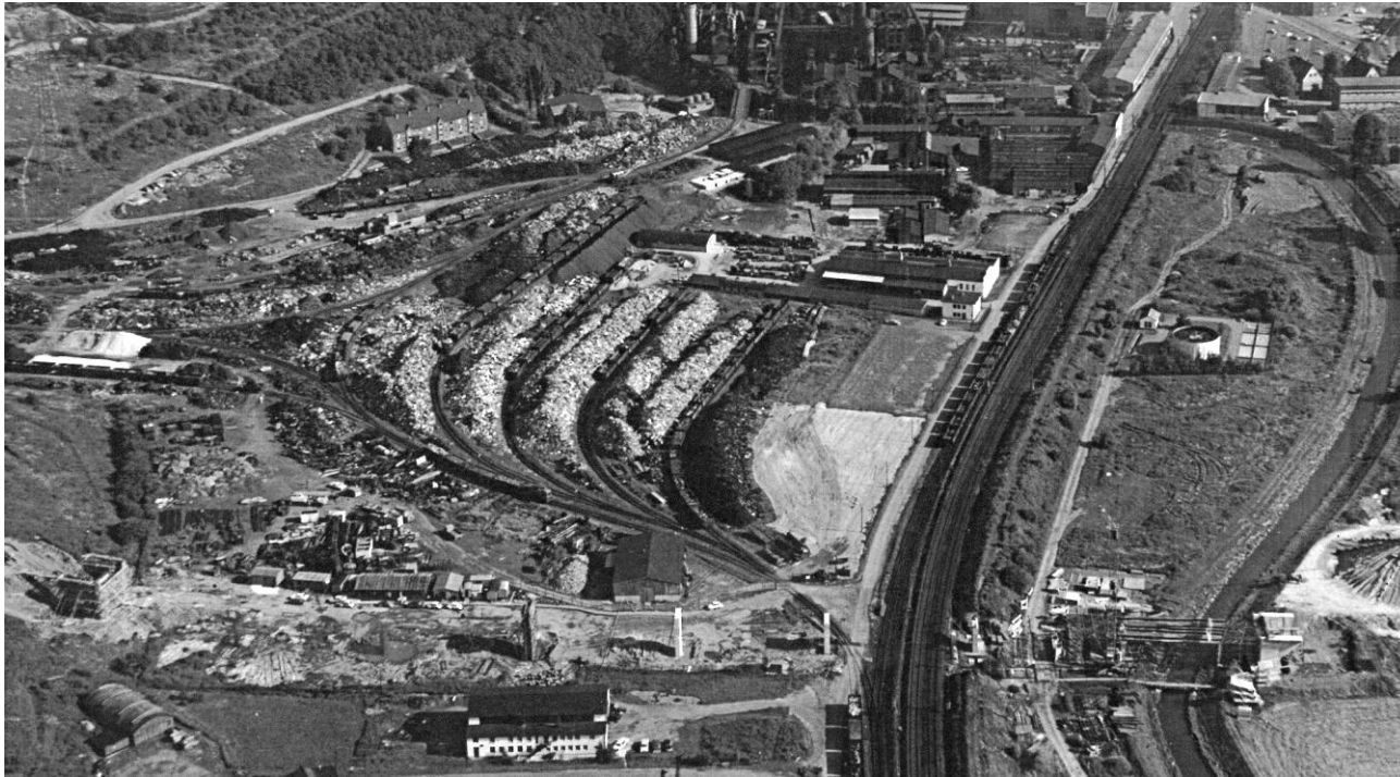
Bau der neuen Setzer Straße
