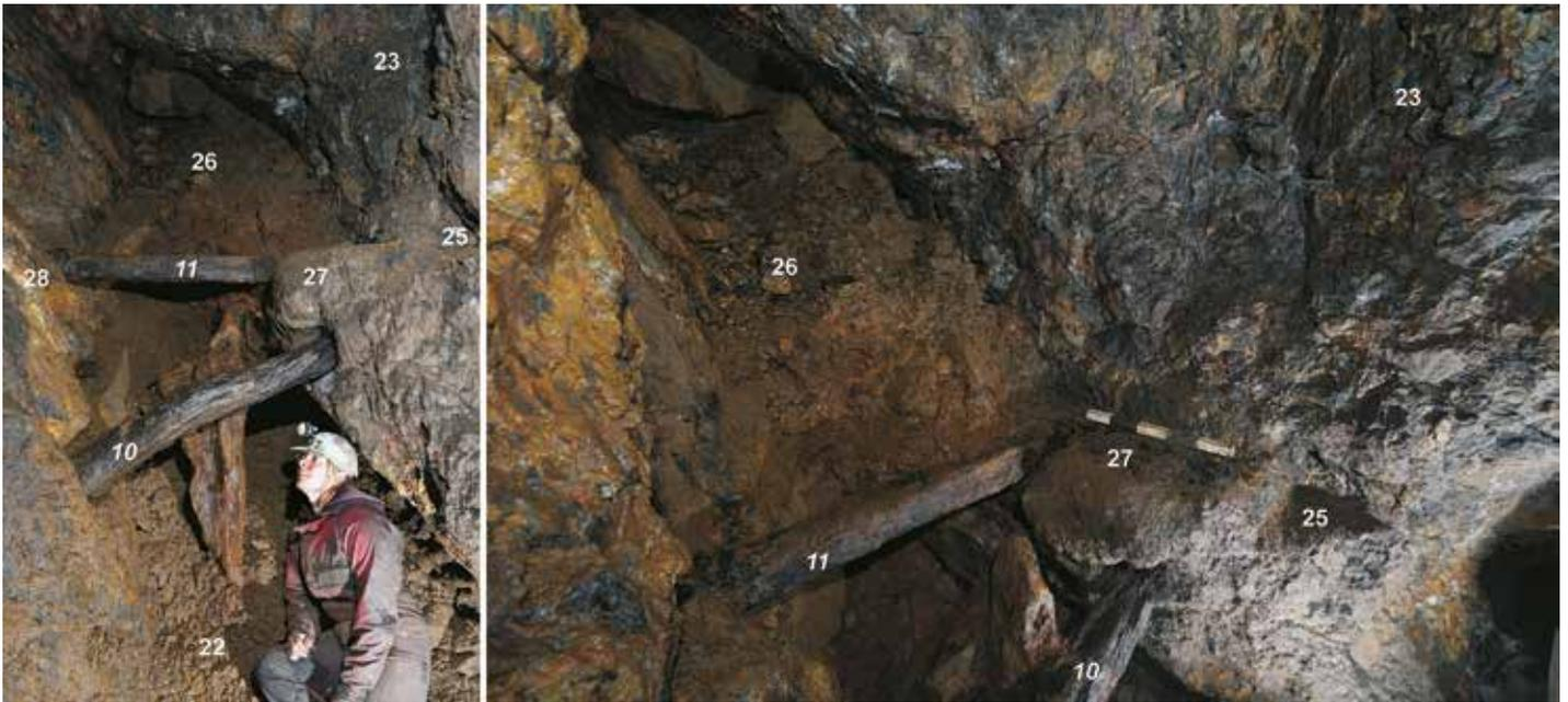
Abb. 19: Kreuztal-Burgholdinghausen, Alter Mann Grube Victoria: Bühnenfragmente und -einrichtungen in Abbaukammer 2 (Befund 26); 10: Spreizholz; 11: Balken; 22: Versatz; 23: Nische; 25: Bühnenloch; 27-28: herausgearbeitete Kanten in den Stößen als Bühnen(-balken)-Unterlage (Fotos: DBM/ P. Thomas; Grafik: LWL-Archäologie für Westfalen/ M. Zeiler)
