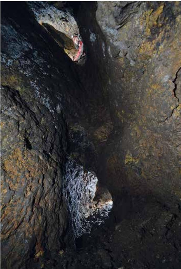
Querschnitts sicher dann kein Förder-, sondern ein Wasserlösungsstollen gewesen sein wird. Der vermutete Stollen mündet parallel neben einem ausgezerten Gang in der Abbaukammer 1 (Befund 35, Abb. 10).
