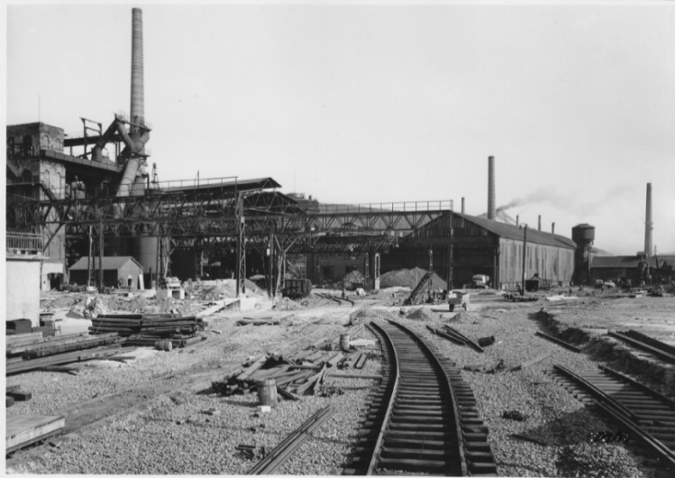
Bau der neuen Halle 6
