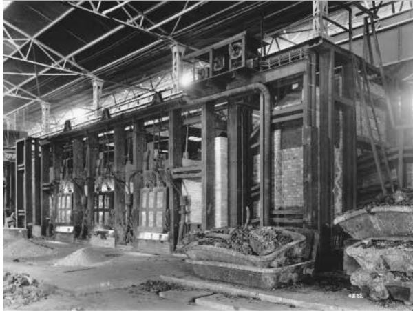
Maerz-Ofen 1, Mai 1951 Oben: Oberofen mit Toren zum Beschicken Unten: Ausmauern des Herdes
