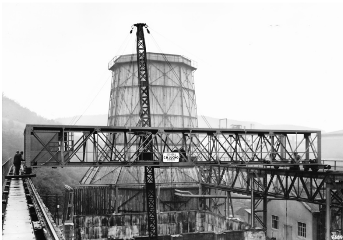
Montage des neuen Fallwerkskrans
