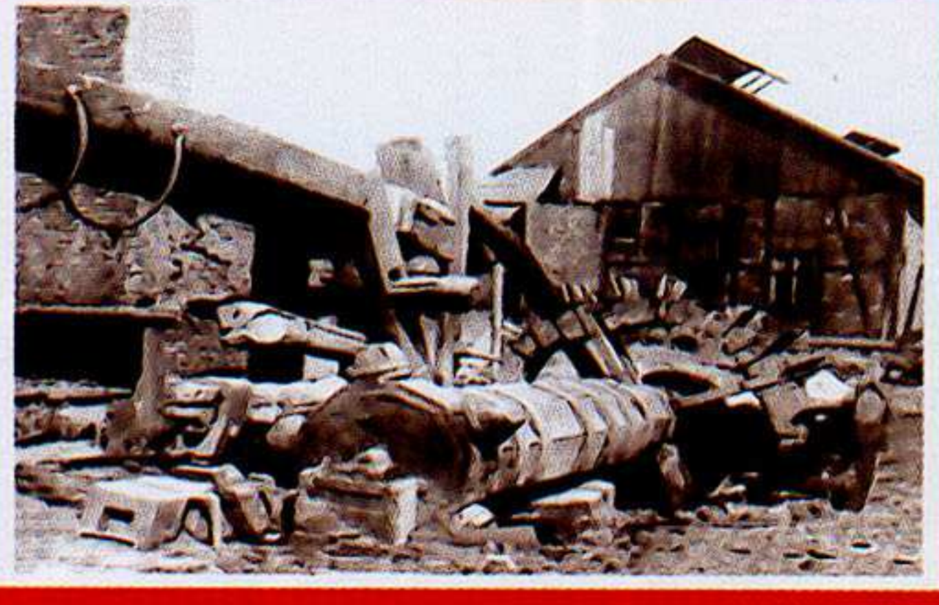
Aufwerhammer mit dem Federbalken (Reitfel) um 1915, Antriebswelle mit den „Fröschen“ und dem mittelschlächtigen Wasserrad, inkl. Zahnradgetriebe für einen dahinter angeordneten Schleifstein
