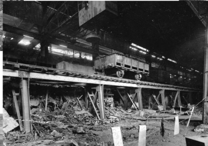
Oben: Das Hochgleis zum Anstellen der Waggons mit Schrott.
