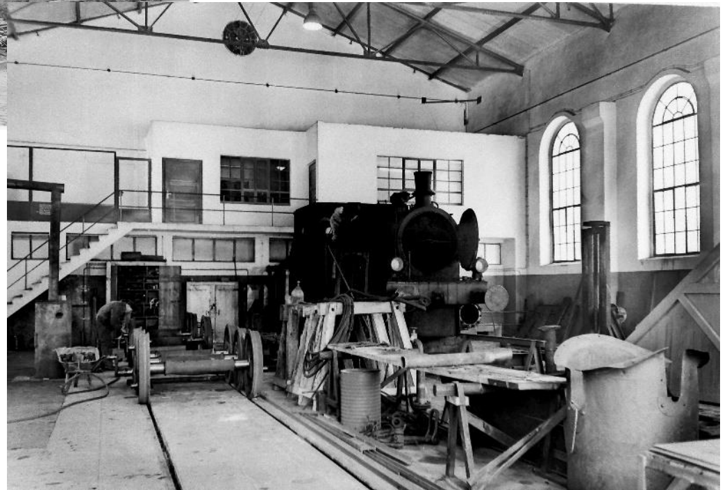
Lokwerkstatt mit Lok 1. Eine „Ct n2 Han“ 10565/27“ von Hanomag
