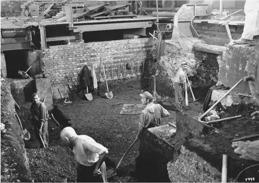
Ausschachtung für den Rollgang hinter der Demag-Schere
