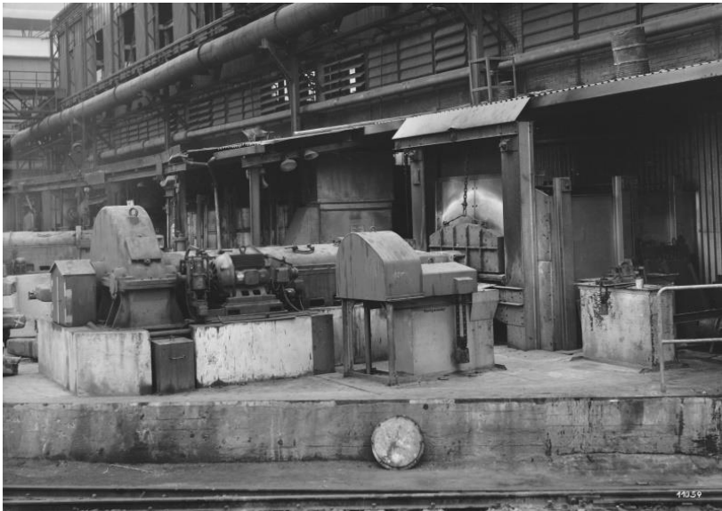
Überholung der Stoßöfen vor der Blockstraße
