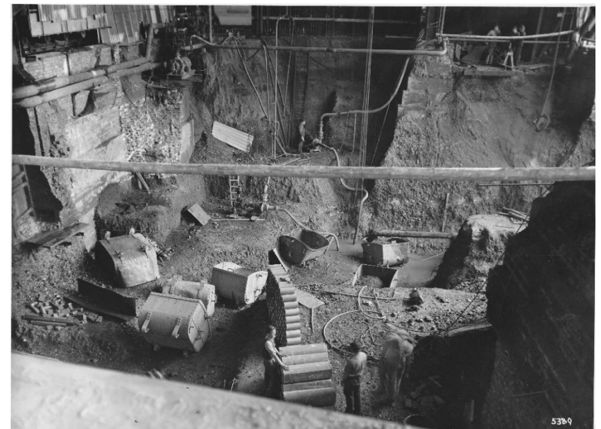
Ausschachten für das 725er-Trio-Walzgerüst
