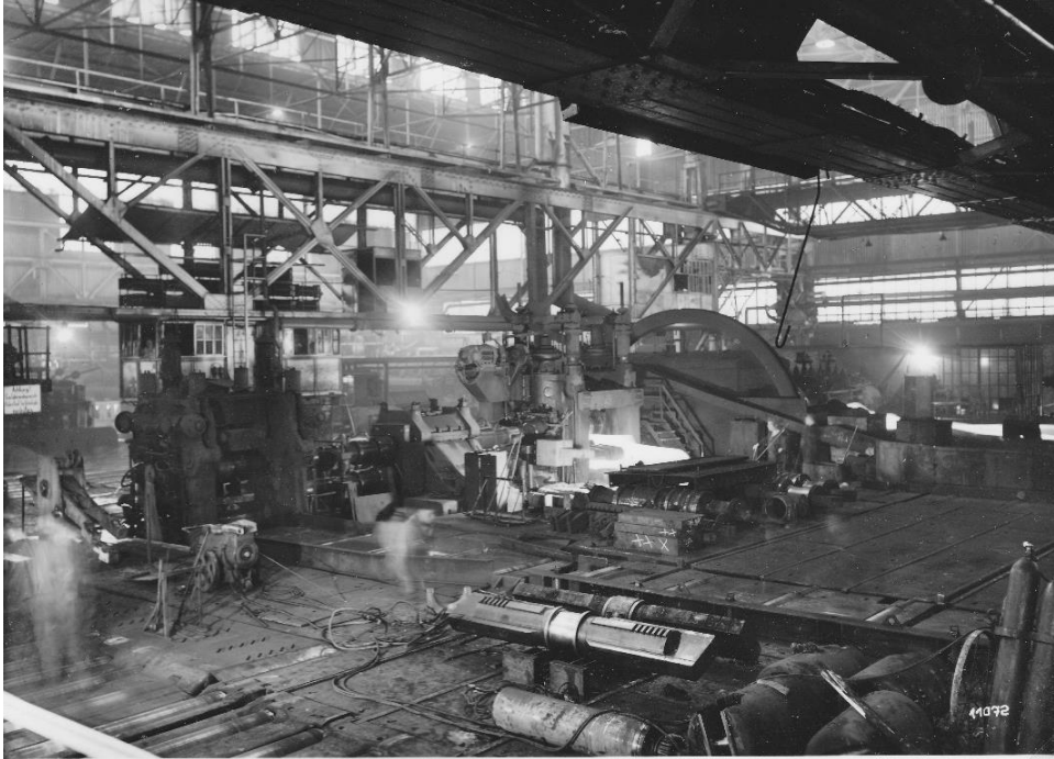
Blockstraße, Gerüst 1 und 2
