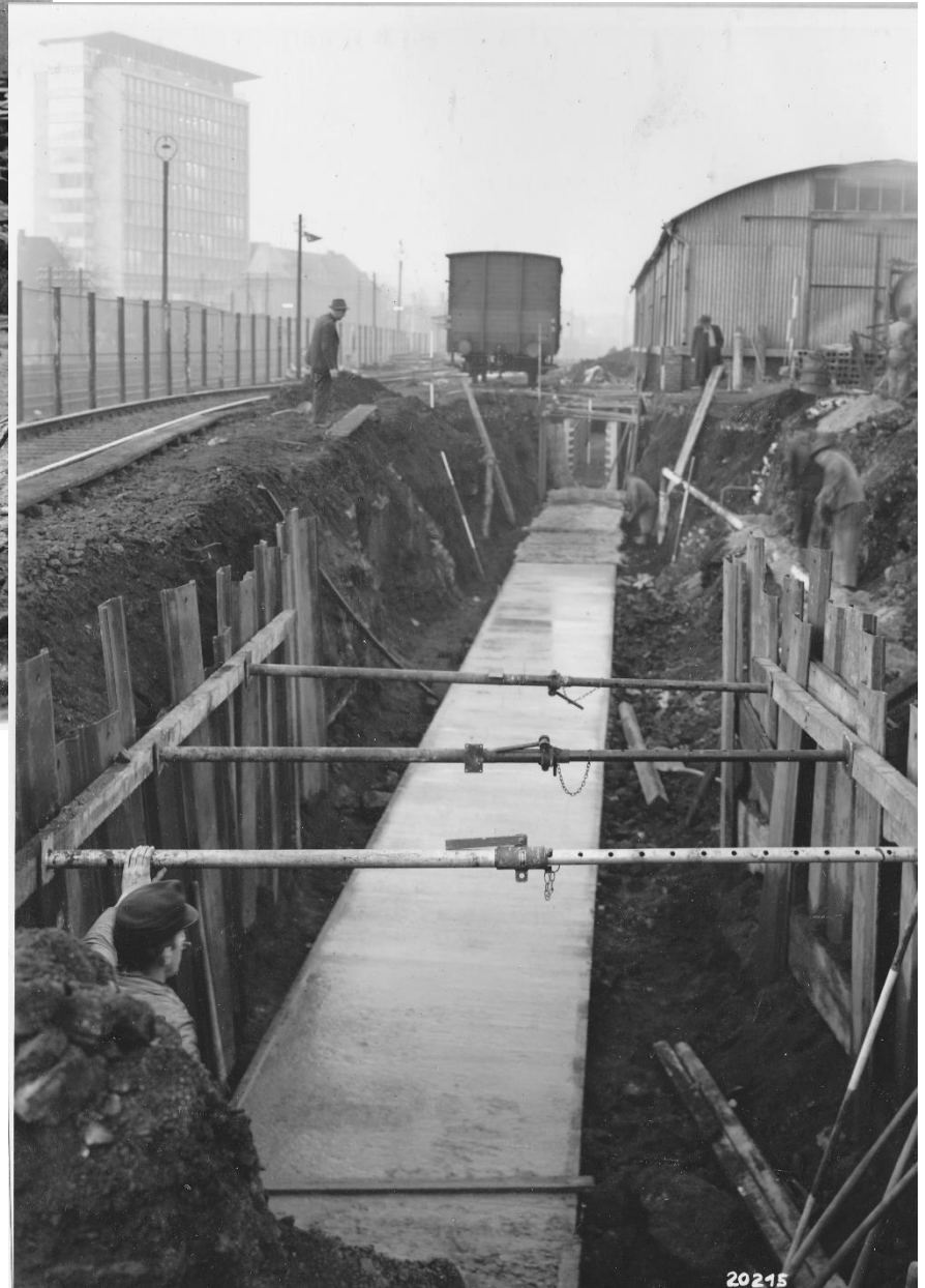
Bau des Nord – Süd – Kabelkanals von der RWE-Übergabestation aus.
