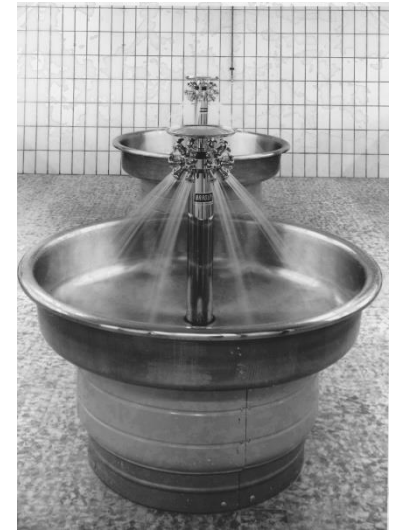
Umbau Generatoren – Gebäude zum Sozialgebäude
