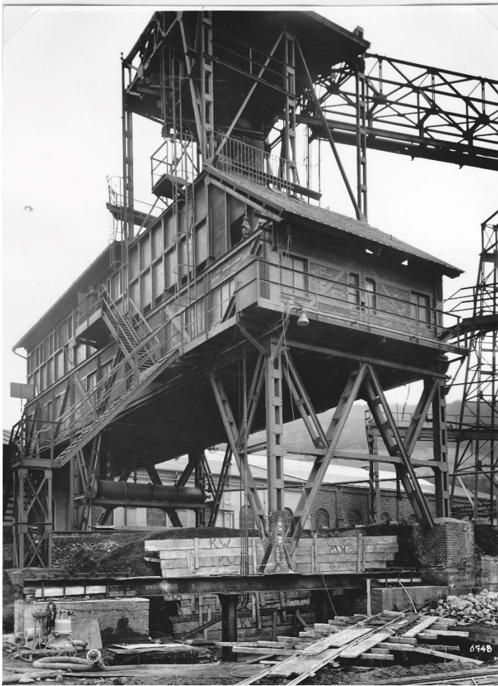
1952: Abstützung der Seilbahnstation
